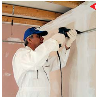
نصب سازه نبشی تراز سقف
