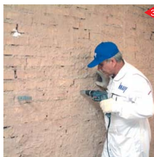
نصب قطعات سازه ای اتصال به دیوار
