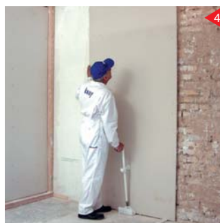
استفاده از جک نگهدارنده برای ثابت نگه داشتن صفحات تا زمان گیرش خمیر پرل‌فیکس
