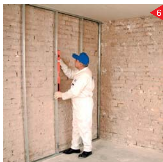
کنترل شاقول بودن سازه های C قرار گرفته در رانر فوقانی و تحتانی
