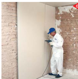
نصب صفحات ریکش دار گچی بر روی زیر سازی فلزی
