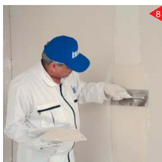
درزگیری با بتونه و نوار درزگیر جهت ایجاد یک سطح یکنواخت
