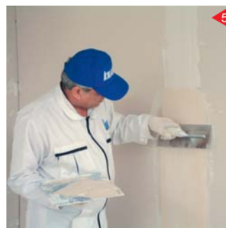
درزگیری با بتونه و نوار درزگیری برای به دست آوردن یک سطح یکنواخت
