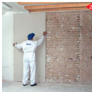
نصب صفحات با توجه به خطوط راهنمای اجرا شده در کف و سقف
