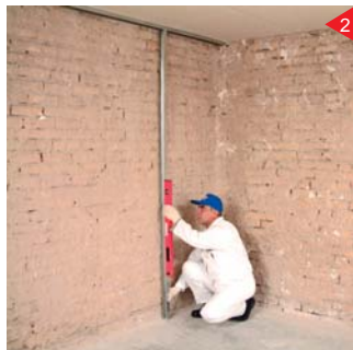
تعیین موقعیت رانر کف بر روی کف به وسیله سازه استاد و تراز
