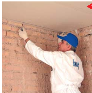
تعیین موقعیت رانر فوقانی بر روی سقف
