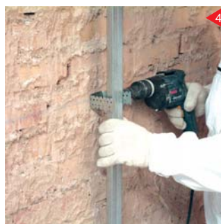
اتصال سازه F47 به قطعه اتصال به دیوار به وسیله پیچ اتصال سازه به سازه کناف در دو طرف
