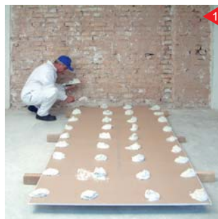
نشاندن شانه های خمیر پرل‌فیکس در فواصل معین بر روی صفحات روکش دار گچی
