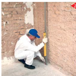
تعیین موقعیت نبشی کف با توجه به نبش سقف به وسیله یک شاخه سازه F47 و تراز
