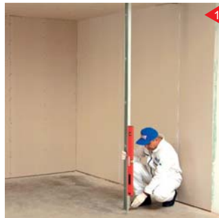
1 بعد از اتصال رانر سقف محل رانر کف به وسیله یک شاخه استناد و یک تراز عمودی مشخص می شود.
