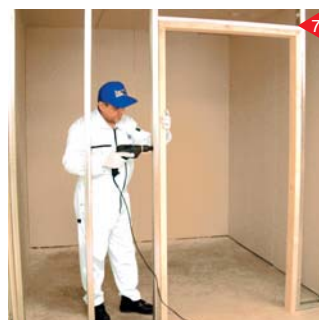
7 اضافه کردن یک شاخه چوب چهار تراش جهت استحکام بیشتر
