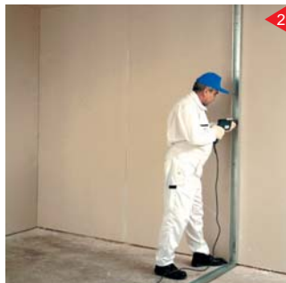
2 قرار دادن استناد برای تکمیل قاب دیوار
