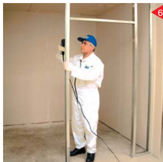
6 خم کردن رانر و اتصال آن به استناد جهت ایجاد قاب در
