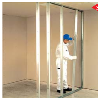
3 قرار دادن استناد داخل رانر کف و سقف
