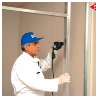
5 برش و خم کردن رانر فوقانی چارچوب و همپوشانی آن با سازه استناد جهت مقاومت و ایستادگی بیشتر قاب
