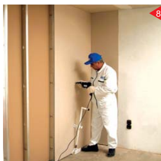
8 اتصال صفحه روکشدار گچی به استنادها
