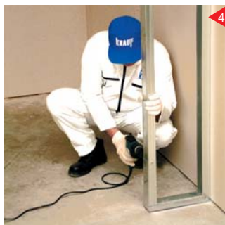
4 برش و خم کردن بخشی از رانر کف و همپوشانی آن با سازه استناد جهت مقاومت و ایستادگی بیشتر چارچوب در
