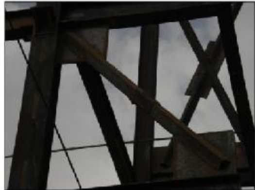
اتصال خارج از محور دستگیر به ورق اتصال و عدم استفاده از ضامنک
