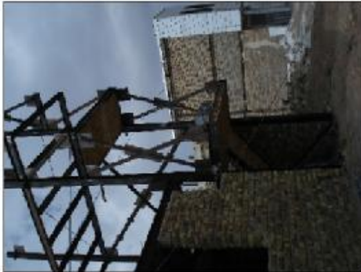
اتصال صحیح دستکها به محل گره اتصال تیر به مستون به عنوان نکته مثبت و اتصال خارج از محور دستک به ورق اتصال به عنوان نکته منفی
