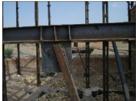
زنجیره ای نبودن جوش، عدم اتصال سخت کننده ها به پال پایین تیر، اتصال بادبند به مرکز اتصال به عنوان تکیه مثبت
