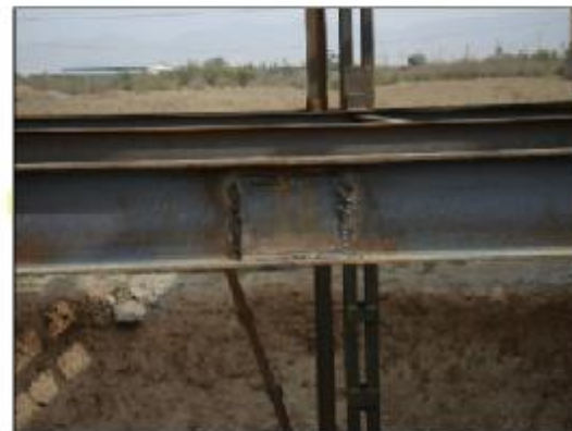
وصله ضعیف تیر تنها با ورق وصله جان بدون ورق وصله پال در حالیکه مقلع وصله قاتم بوده و پنه ای نمیباشد
