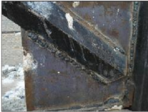
زنجیره ای نبودن جوش و وجود تپچه در آن
