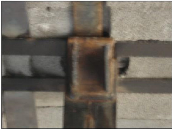
عدم قرار گرفتن سخت کننده در زیر جان تیر، عدم قرارگیری مناسب تیر بر روی نشیمن
