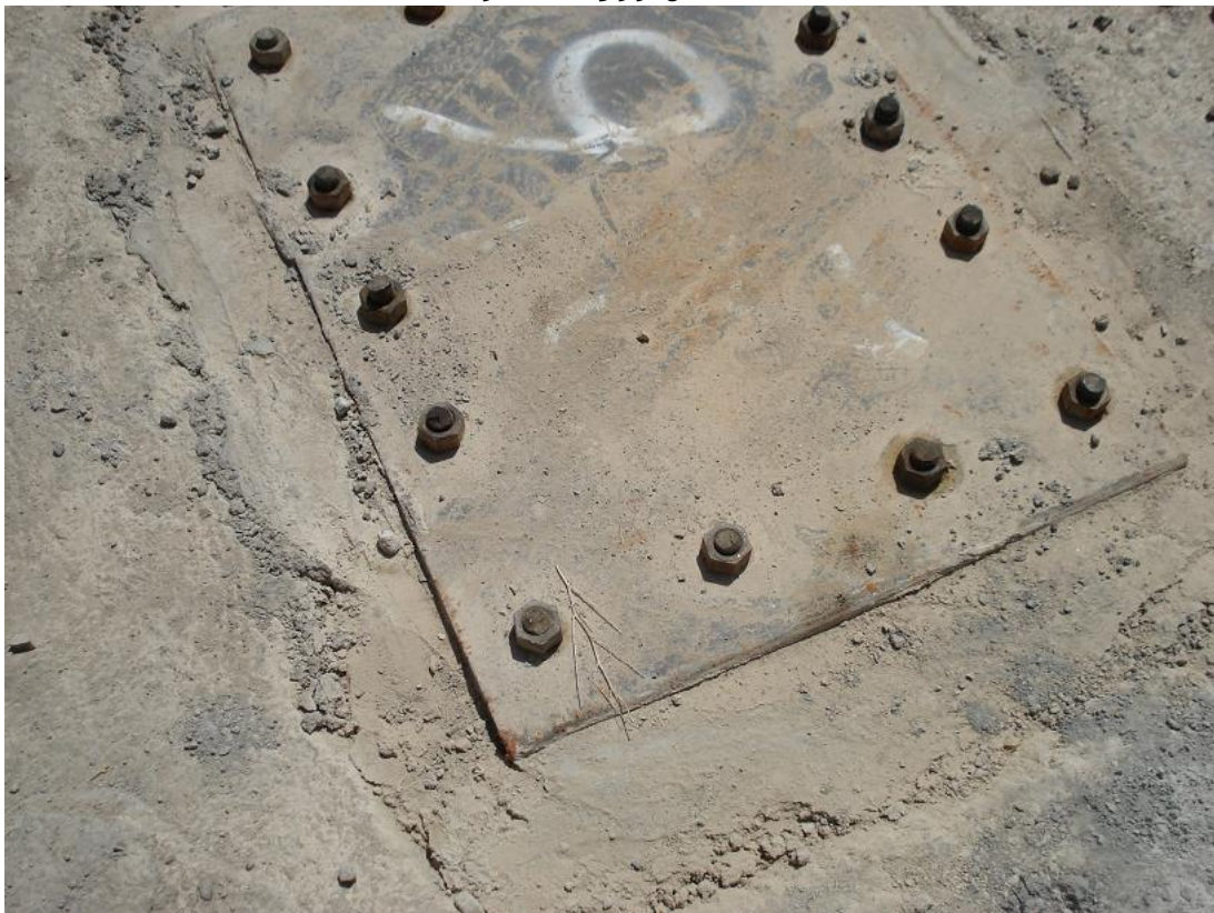
طول رزوه کم بولت اتصال صفحه ستون به پی عکس از زاویه ای دیگر:
