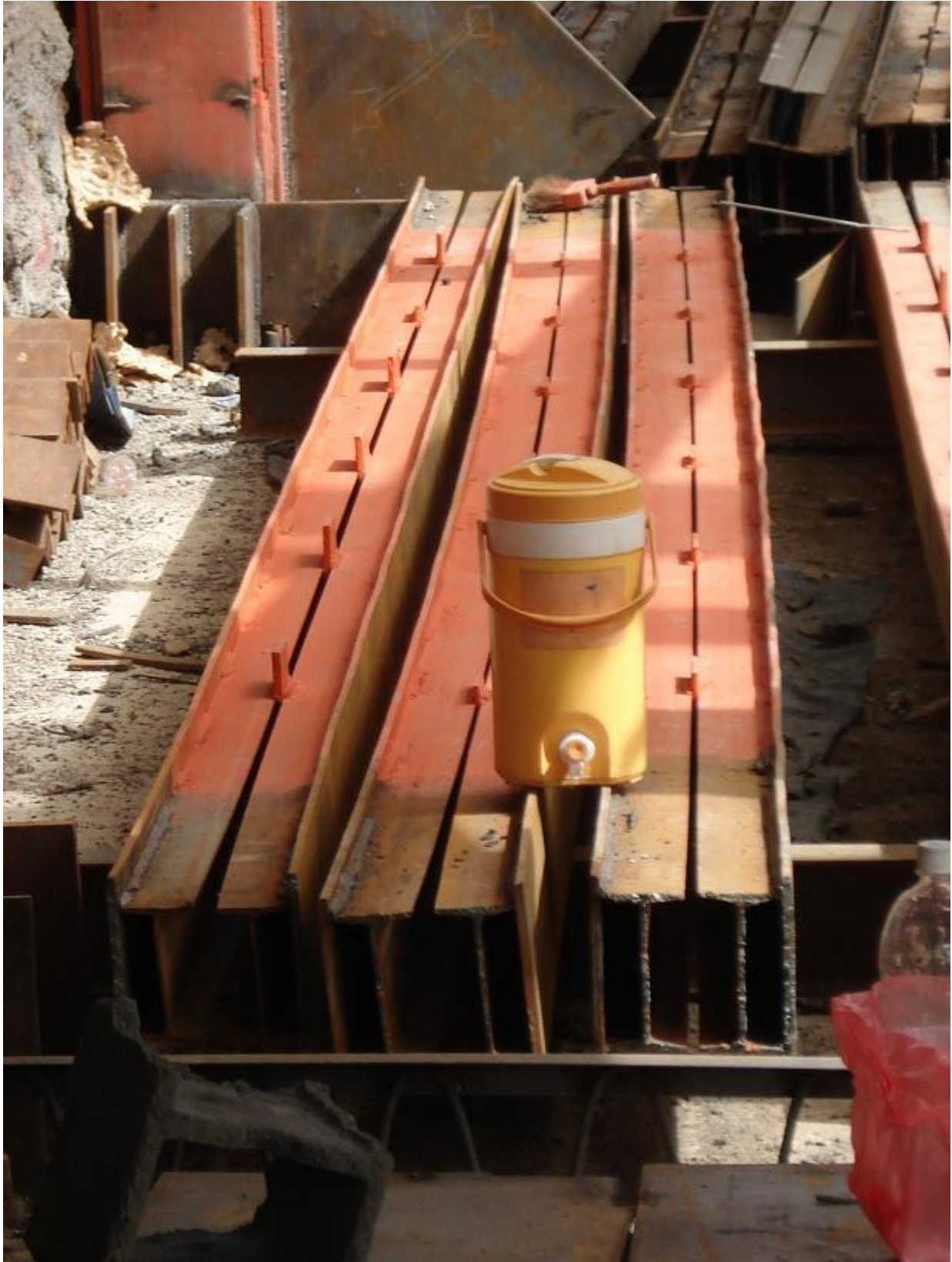
جان است. به و دو قطعه ورق تقویت به موازات IPE پروفیل مرکب بادیست. پروفیل شامل دو قطعه شکل بالا مربوط به سه خیلی واضح نیست و شاید هم خطای دید باشد و علت گرمای جوشکاری مقداری انحنای در این قطعات به وجود آمده است. (البته
