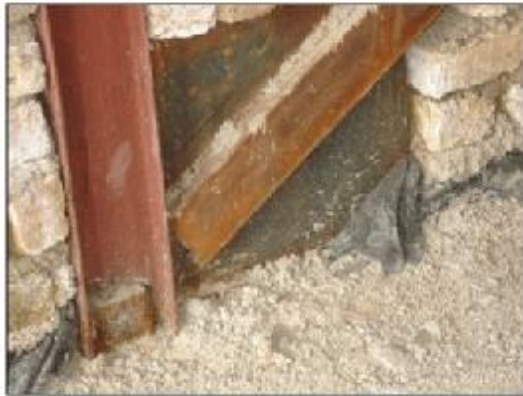
کوچک بودن ورق اتصال پادبند به صفحه سنگین
