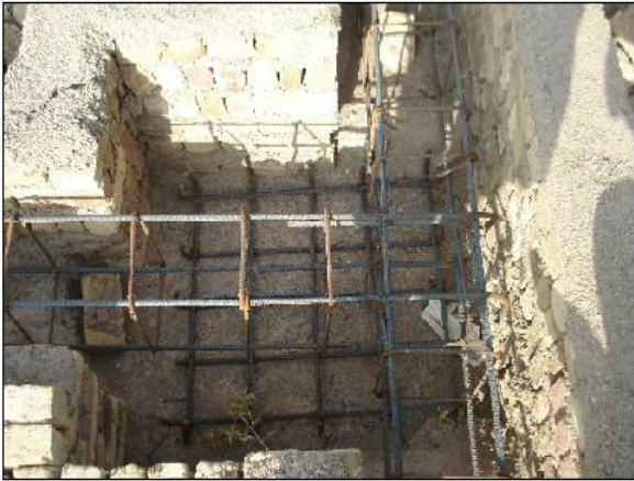
عدم استفاده از پی باسکولی برای ستون قرار گرفته در گوشه
