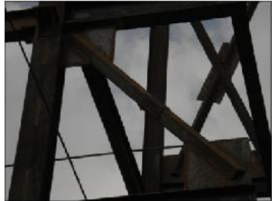
اتصال خارج از محور دستک به به ورق اتصال و عدم استفاده از خاسرنگ
