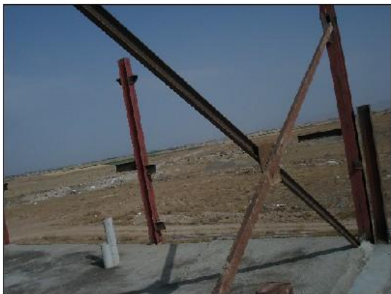
استفاده از مقطع تک برای بادبند
