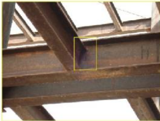
عدم وجود نبشی در اتصال تیر فرعی به تیر اصلی در سمت راست تیر
