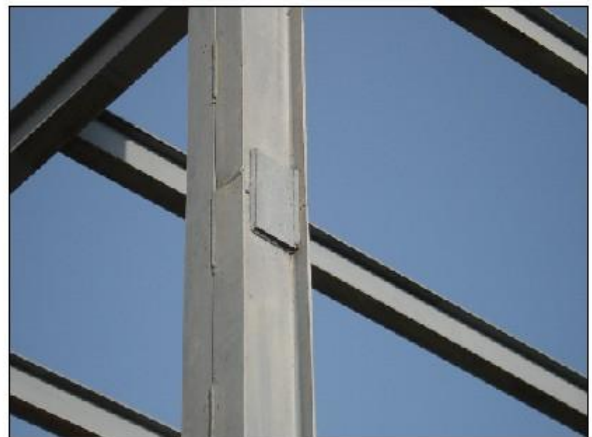
وصله ناقص ستون بدون استفاده کامل از ورق وصله بال
