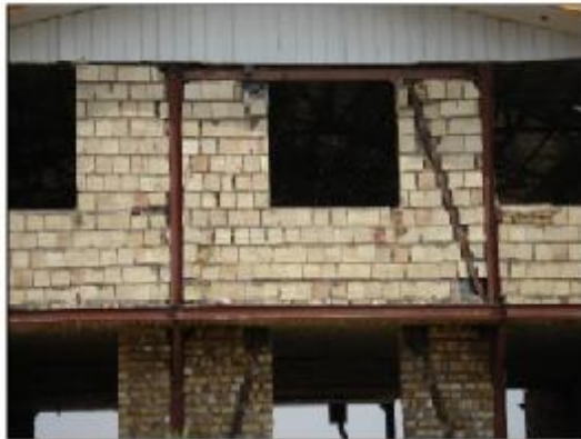
استفاده نامناسب از پادبند های برون محور
