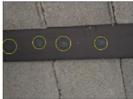
گذاختگی در ورق زیرین تیرچه گرومیت در اثر جوشکاری نامناسب ورق به میلگرد قطری این تیرچه
