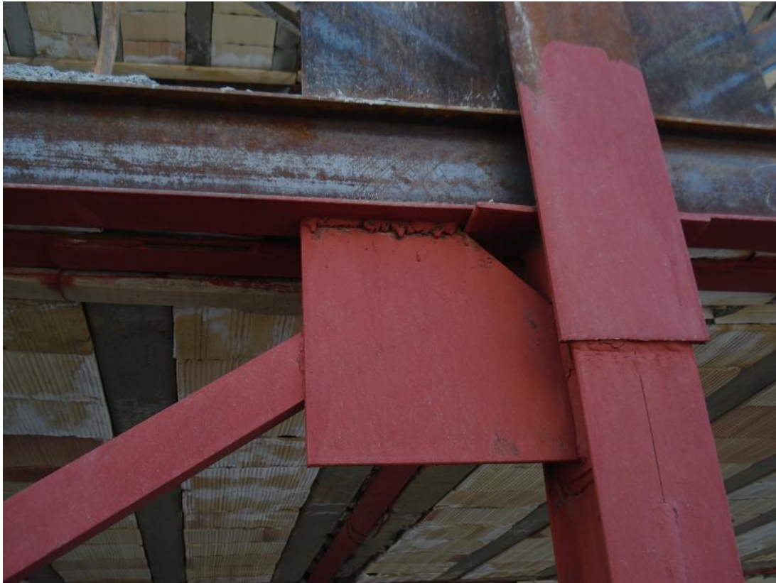
برش قسمتی از گوشه ورق بادبندی که باعث کاهش طول جوش افقی و عمودی شده است . در این زمینه در قسمتهای قبل توضیح داده شده است
