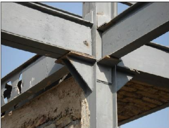
استفاده از ورق و سخت کننده برای اتصال پلها به عنوان یک نکته مثبت
