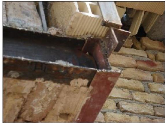
اتصال تیر فرعی به اصلی بدون استفاده از نبشی جان
