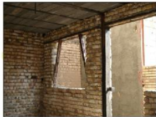
اجرای تیر حمل درگذا به عنوان نکته مثبت و استفاده نامناسب از پادبند پرون محور به عنوان نکته منفی
