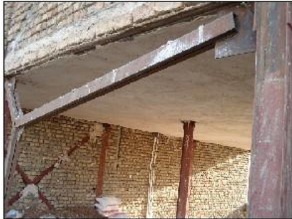
عدم استفاده از نقشه برای اتصال مقطع دوبل بادبند
