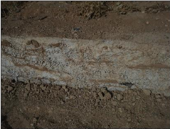
کرمو بودن بتن
