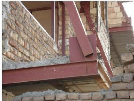
اتصال خارج از محور دستک به ورق اتصال
