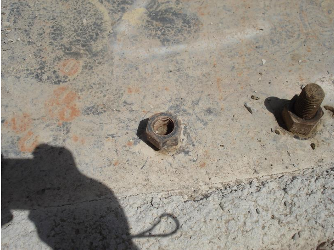
طول رزوه کم بولت اتصال صفحه ستون به پی عکس از زاویه ای دیگر:
