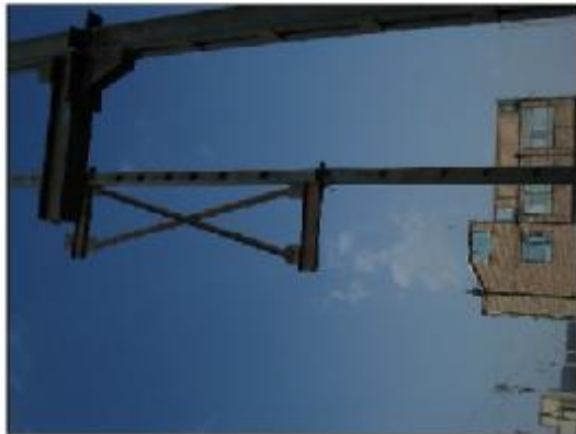
اتصال مناسب دستک به تیر به ستون به عنوان نکته مثبت و اتصال خارج از محور دستک به ورق اتصال چنوبی تیر به عنوان نکته منفی
