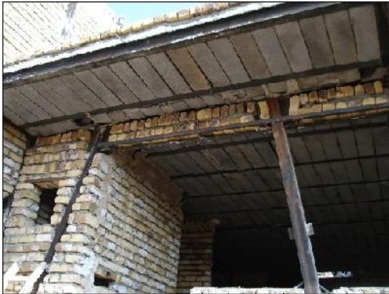
استفاده نامناسب از بادبند برون محور
