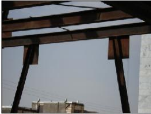
استفاده نامناسب از بادبندهای برون محور، برون محوریست بادبند نسبت به ورق اتصال
