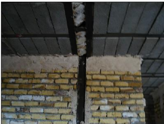
عدم استفاده از ورق بست بزرگ در تیر خوچینی برای اتصال دو تیر در مجاورت اتصال تیر به ستون
