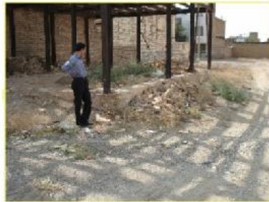
بالا بودن تراز پی نسبت به کف کوچه که خطر یخزدگی را ایجاد میکند
