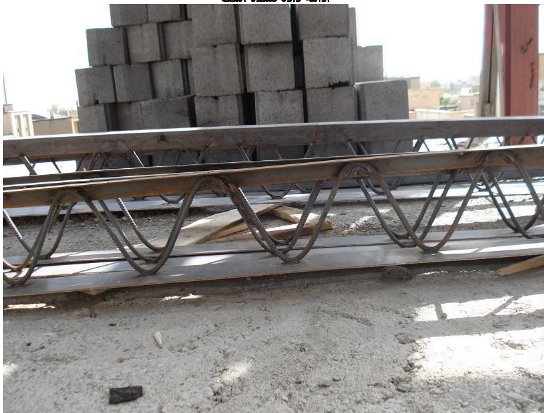
طول جوش کم میلگرد قطری به ورق پایین در تیرچه کرمیت عکس بالا یک تیرچه کرمیت را نشان میدهد. همانطور که مشخص است میلگردهای قطری به ورق پایین تیرچه طول تماس کمی دارند و در نتیجه طول جوش کمی نیز جهت اتصال آن دو موجود است. البته در نشریه 151 به ظاهر ضابطه خاصی وجود ندارد ولی به نظر میرسد که برای انتقال نیروها بین ورق پایین و میلگرد قطری حداقل حدود سه سانتیمتر طول تماس افقی بین این
