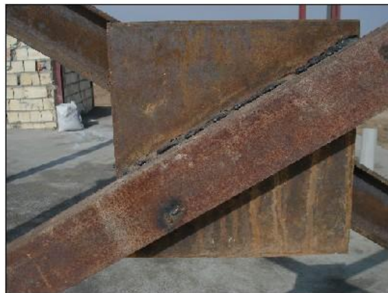
عدم استفاده از ضدزنگ، زنجیره ای نبودن جوش
