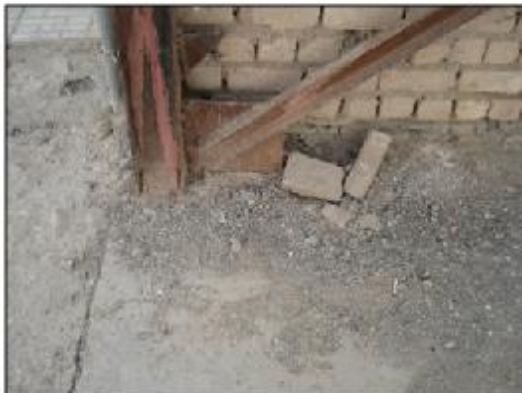
ورق اتصال کوچک برای اتصال بادبند به صفحه ستون، زنگردگی قطعات، استفاده از مقطع تک برای بادبند
