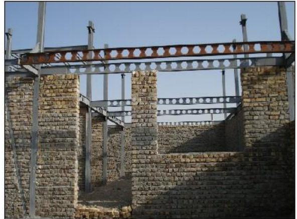
عدم وجود ضدزنگ کامل و اتصال دستی به دل ستون
