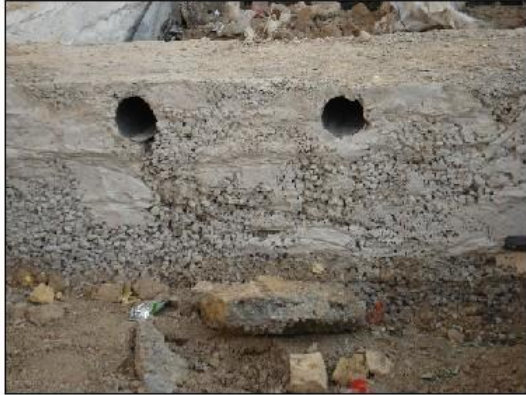
سوراخ کردن پی برای عبور لوله و گرمو بودن بتن پی
