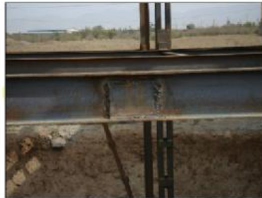
وصله ضعیف تیر تنها با ورق وصله جان بدون ورق وصله پال در حایکمه مقلع وصله گاتم بوده و پله ای نمیباشد
