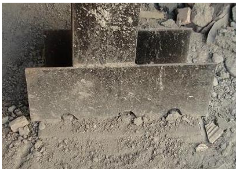
بریدن قسمتهایی از سخت کننده در صفحه ستون به علت تداخل با بولتها در صفحه ستون بالا به علت بیدقتی طراح و یا بی توجهی در زمان اجرا بولتها و سخت کننده صفحه ستون در یک محل قرار گرفته اند که این مساله باعث شده است که برای رفع مشکل قسمتهایی از سخت کننده را در محل تداخل با بولتها بریده شوند. این مساله ضمن تضعیف سخت کننده باعث کاهش طول جوش اتصال سخت کننده به صفحه ستون هم میشود . عکس بزرگتر از این اتصال را از لینک زیر مشاهده نمایید :
