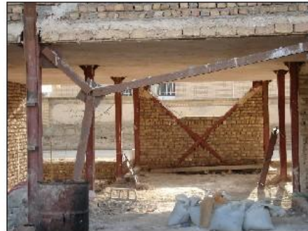
استفاده از بادبند نامناسب برده ای
