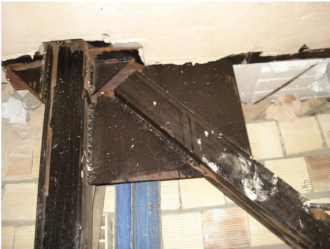
ورق بادبندی در محل تلاقی با نشیمن اتصال تیر به ستون برش قسمتی از
