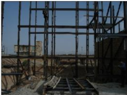
عدم مهارت کشی دور گود برای جلوگیری از سقوط عابران در گود
