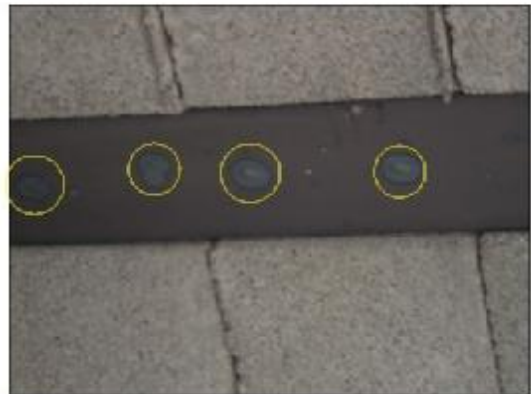
گذاختگی در ورق زیرین تیرچه کمره در اثر جوشکاری نامناسب ورق به میلگرد قطری این تیرچه
