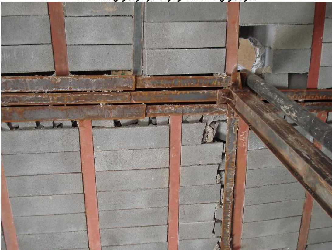
شکل بالا یک پل سه تایی را از زیر سقف نمایش میدهد.
