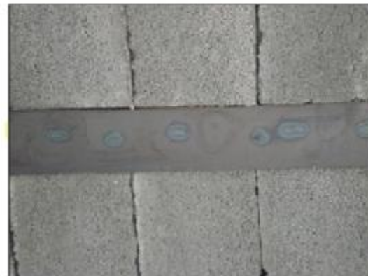
سوختگی ورق زیرین تیرچه کرمیت در اثر جوشکاری نامناسب ورق به میگره قطری تیرچه
