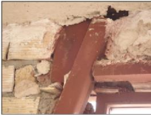
اتصال خارج از محور پادبند به ورق اتصال
