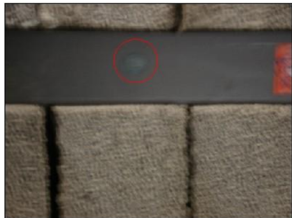
ایجاد گداختگی در ورق پایین تیرچه کرومیت در اثر جوشکاری ورق به میلگرد قطری
