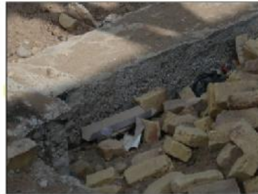
گرم بودن بتن پی
