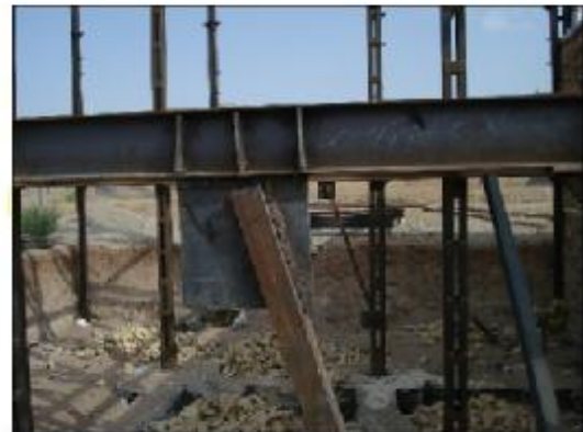
زنجیره ای نبودن جوش، عدم اتصال سخت کننده ها به پال پایین تیر، اتصال پایدندی به مرکز اتصال به عنوان نکته مثبت
