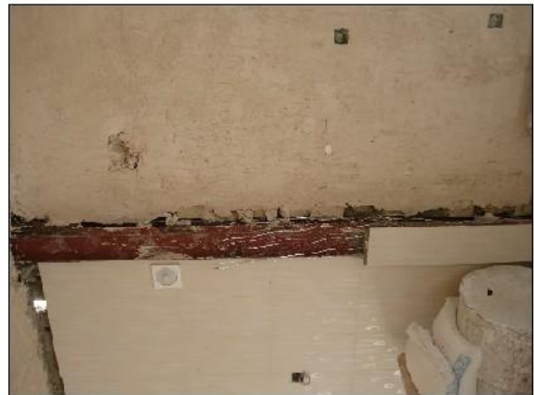
عدم اجرای کامل توری سیمی یا رابیتس بندی در دور ستون
