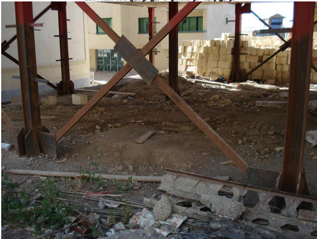
استفاده از مقطع تک برای بادبند
