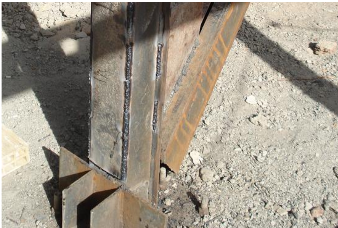
در عکس بالا ورق تقویتی ستون در بالای تراز سخت کننده اتصال ستون به صفحه ستون قطع شده است و تا روی صفحه ستون ادامه داده نشده است
