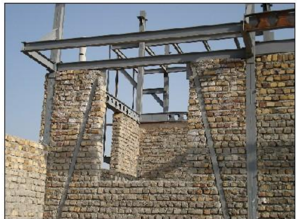
استفاده نامناسب از بادبند بیرون محور
