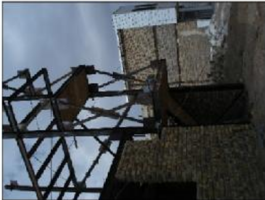
اتصال مسطح دستگیر به محل گره اتصال تیر به ستون به عنوان نکته مثبت و اتصال خارج از محور دستگیر به ورق اتصال به عنوان نکته منفی
